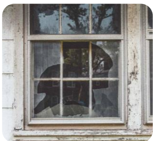
Ventanas sin laminar
